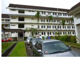
施工場所① UTM
