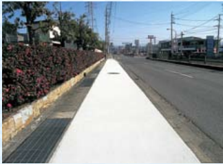
岐阜県多治見市光ヶ丘4丁目 (一般国道248号線歩道 第1期) 【樹脂コートタイプ】
