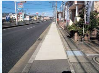
岐阜県多治見市光ヶ丘4丁目 (一般国道248号線歩道 第2期) 【樹脂コートタイプ】
