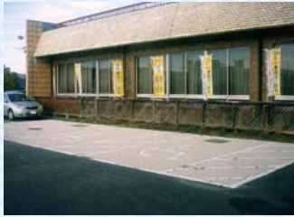
岐阜県土岐市役所駐車場 【樹脂コートタイプ】
